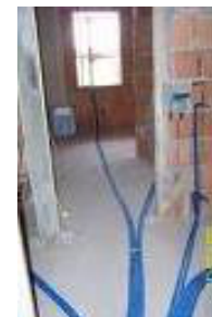
Impianti interni in opera
