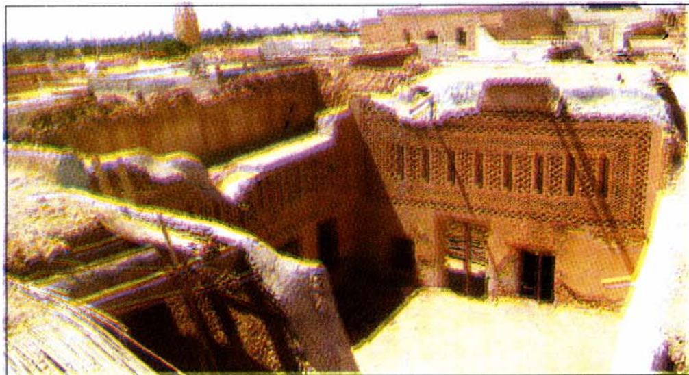
L'annexe de Dar el Ouadi en cours de restauration
