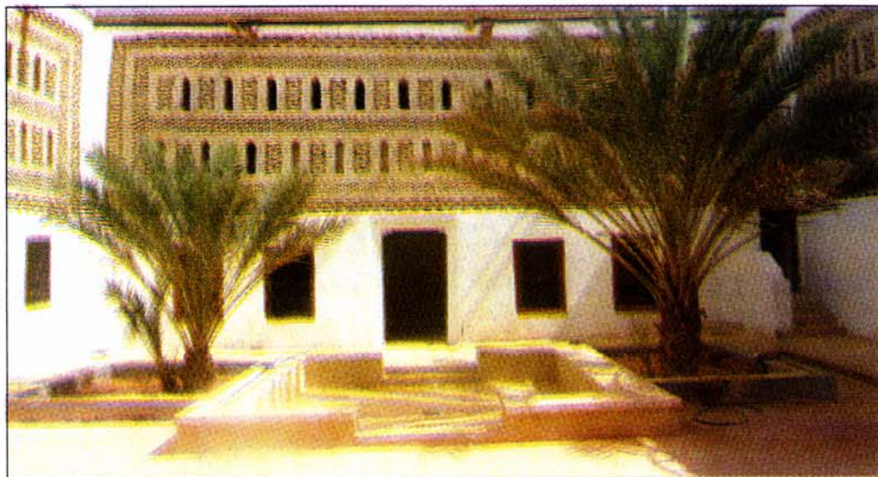
Dar el Ouadi, siège du "Projet pilote de Nefta" après restauration
