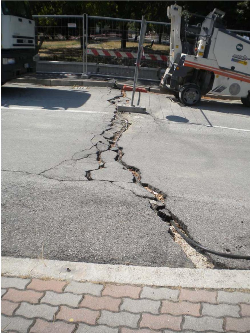
Fratture nell'asfalto dovute a liquefazione a S. Carlo.
