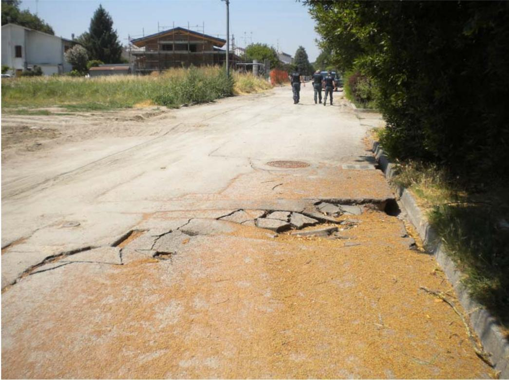
Fratture nell'asfalto dovuti a liquefazione a S. Carlo.
