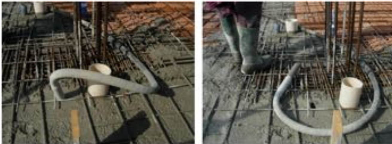
Costipamento dell'impasto nella cassaforma tramite vibratura
